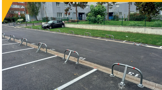
Parking après les travaux
