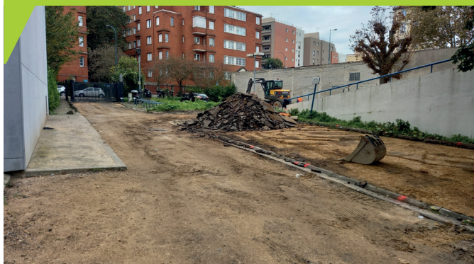
Parking pendant travaux
